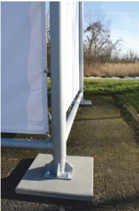
Stahlstandpfosten mit Knotenblechen und Sockelplatte, verzinkt.
